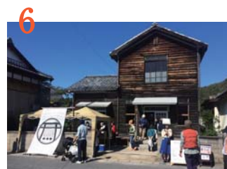
6 大三島みんなの家 大山祇神社参道の空き家を、 だれもが気軽に集える場に改修
